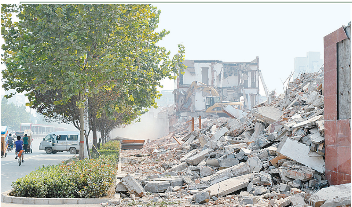
昨日上午,在航海路与碧云路交叉口西20米处的华中食品城拆迁现场,施工人员正在拆除路边建筑物。由于没有设置任何围栏和挡板,灰尘被风吹向路面,行人几乎睁不开眼睛,过往市民呼吁拆迁作业人员文明施工,切莫污染城市环境。
