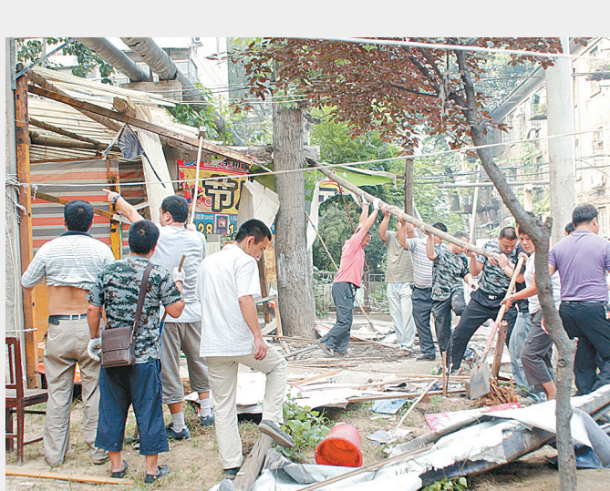
棉纺路办事处工作人员正在拆除辖区违章建筑。
