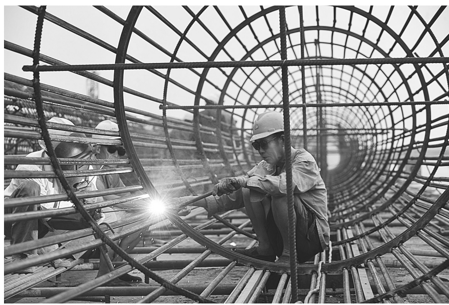
昨日,在武西高速公路郑州桃花峪黄河公路大桥建设施工现场,中铁大桥集团一公司的工人师傅正紧张奋战在工地上。据了解,郑州桃花峪黄河公路大桥是郑州市境内规划的第四座跨黄河公路大桥,设计全长7691.5米,全线采用双向六车道高速公路技术标准,工程计划于2013年4月完工。 本报记者 丁友明 摄
