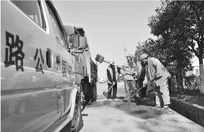
连日来,市公路局集中大批人员、设备,对所辖出入口公路开展卫生清理行动。昨日,公路保洁人员在绕城高速公路大学路出入口附近清理路边垃圾。
