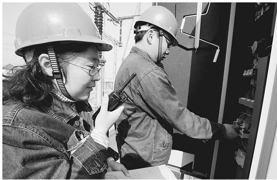
冬季是用电高峰,为保障市区用电,昨日,郑州供电公司试验部对500千伏香郑线开展保护定检,全面检验香郑线保护及二次回路的正确性,确保河南电网安全稳定运行。
