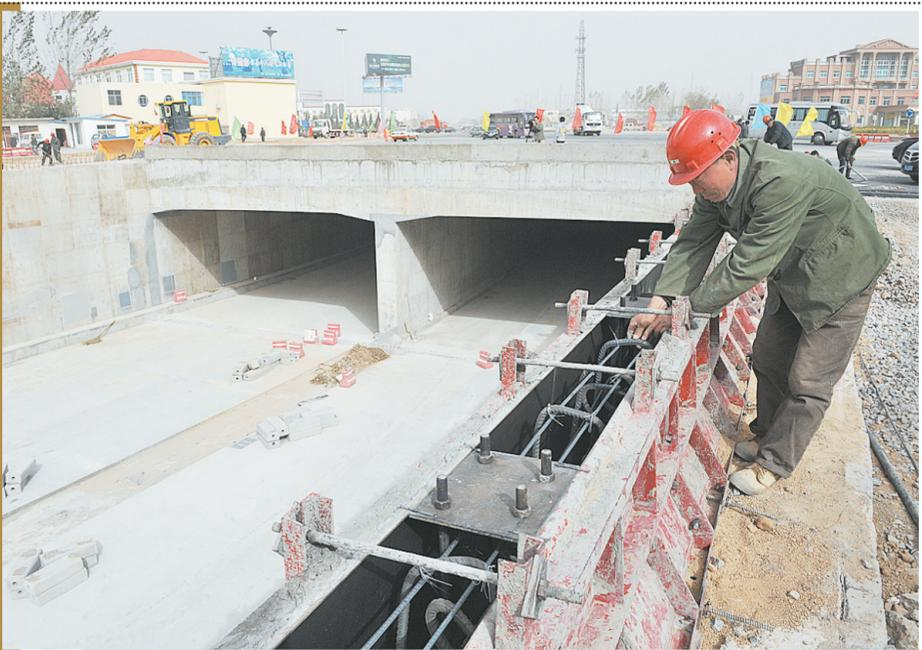
昨日,记者从郑州交通重点工程建设管理中心了解到,由中铁十五局集团五公司承建的国道107线与新郑机场路互通立交隧道工程,目前路基工程、路面基层、隧道主体工程、雨水管工程已全部完成,路面部分已实现通车。据了解,该工程总投资10101万元,路基宽度60米,道路设计速度每小时100公里,对缓解郑州的交通压力,完善航空港区的路网建设有极大的促进作用。本报记者 许大权 摄
