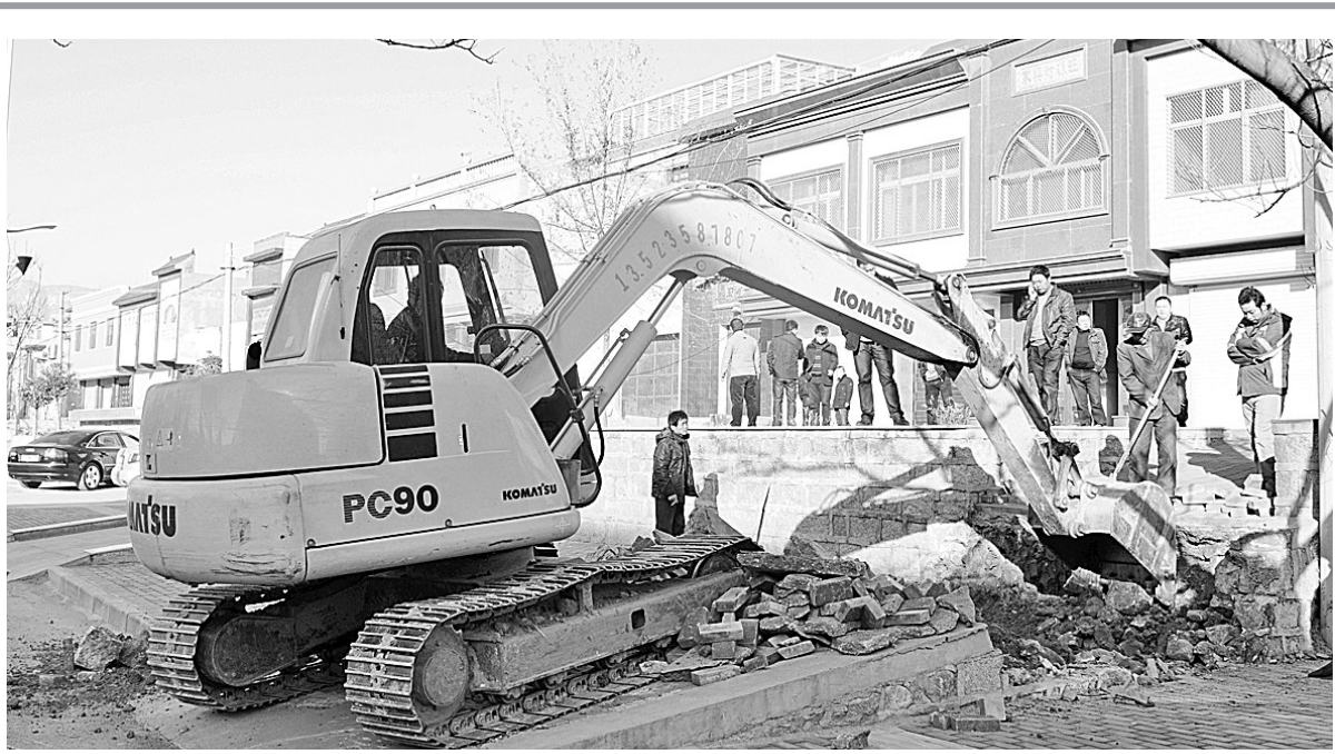
近日,登封市住房和城乡建设局出动工作人员20多人、挖掘机2台、工程车辆12台对公园北路和崇福路段擅自搭建缓坡的违章建筑进行了集中拆除整治。同时,该局表示,将尽快在这些拆除填埋缓坡的地方铺设环保砖,保障人行道完好,进一步改善和优化城市道路交通环境。
