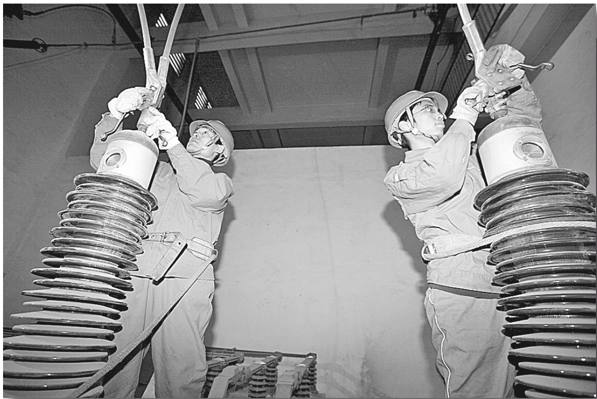
昨日凌晨3时,经过96小时的日夜奋战,郑州供电公司顺利完成对110千伏王砦变I王支线路电缆故障抢修,恢复了南阳路以东、北环以北区域的正常供电。其间,该公司60名工人冒着7级大风和-8℃严寒,24小时连续作业。图为工人在现场做电缆耐压试验。 本报记者 丁友明 摄
