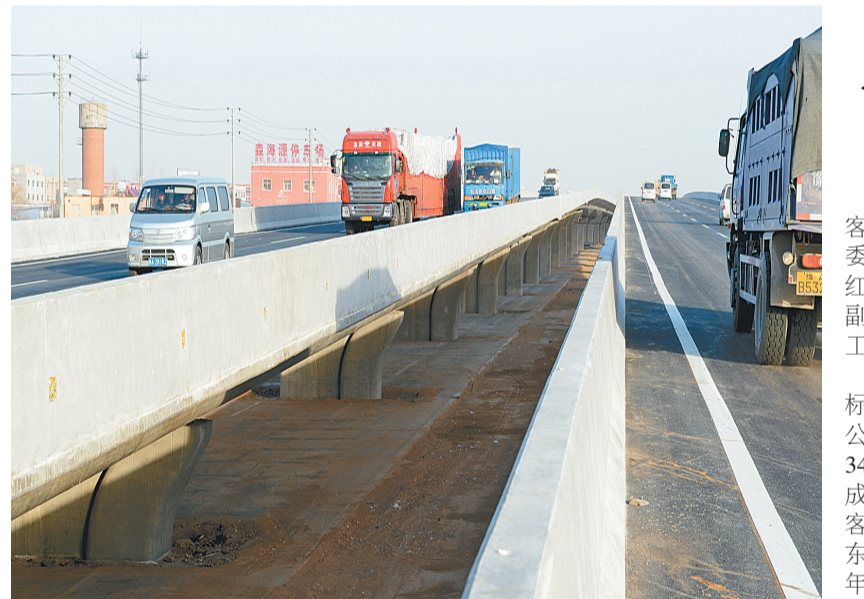
嵩山南路与南四环立交桥昨日通车。本报记者 许大桥 摄
