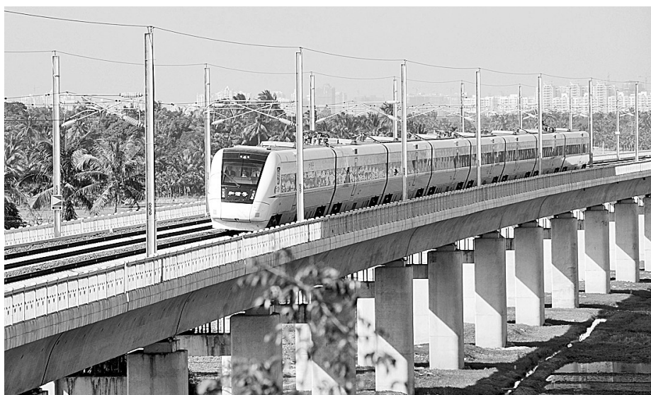
12月26日,“和谐号”列车行驶在海南东环铁路上。海南东环铁路在进行了一个多月的前期检测之后,于12月24日开始试运行。据介绍,海南东环铁路将于12月底或2011年1月初正式投入营运。海南东环铁路项目于2007年9月开工,线路全长308公里,总投资202亿元。东环铁路北起海口市,途经文昌市、琼海市、万宁市、陵水县,南至三亚市,全线初期开设10个车站。通车后,乘客从海口至三亚仅需90分钟。 新华社发
