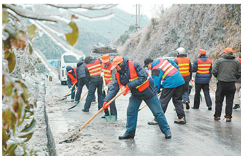
广西资源县公路管理局的职工在资源县通往兴安至桂林的公路上铲除路上的冰雪。本组图片均为新华社发
