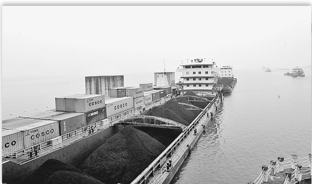
1月5日,货轮通过三峡船闸上游开进南一闸室下行。 长江三峡通航管理局的最新统计显示,2010年三峡双线五级船闸通过货运量达7880万吨,创历史新高。此外,坝前转运货物914万吨,过坝货运总量达到了8794万吨,同比增长18.44%。 新华社发
