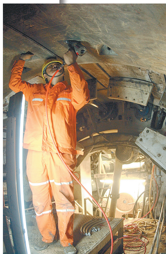
▼施工人员为隧道管片固定好每一枚螺栓。
