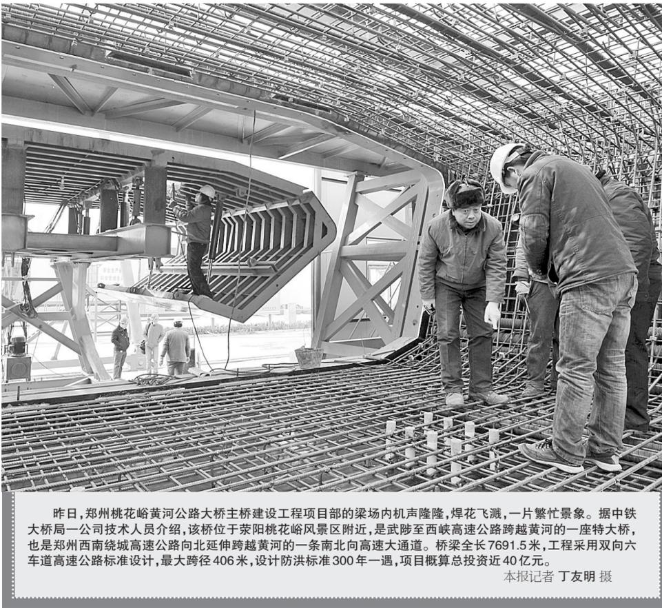
昨日,郑州桃花峪黄河公路大桥主桥建设工程项目部的梁场内机声隆隆,烟花飞溅,一片繁忙景象。据中铁大桥局一公司技术人员介绍,该桥位于荥阳桃花峪风景区附近,是武陟至西峡高速公路跨越黄河的一座特大桥,也是郑州西南绕城高速公路向北延伸跨越黄河的一条南北向高速大通道。桥梁全长7691.5米,工程采用双向六车道高速公路标准设计,最大跨径406米,设计防洪标准300年一遇,项目概算总投资近40亿元。
