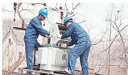
▲ 电力职工正在争分夺秒地架设新的变压器
