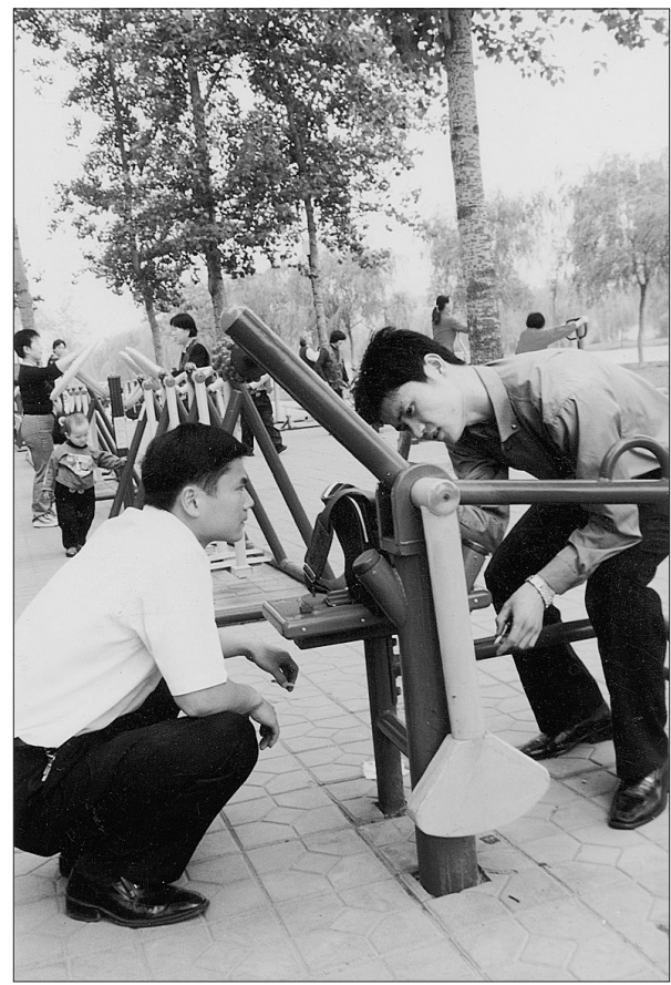
厂家工作人员对户外健身设施进行维修
