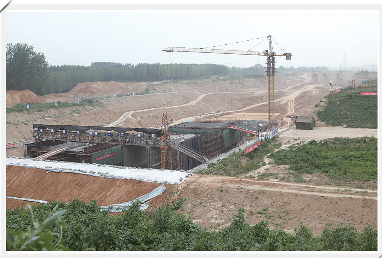
南水北调中线工程干渠开挖进展顺利
