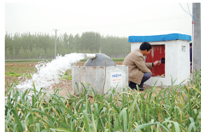
中牟县杨桥灌区田间先进的射频IC卡智能灌溉大见成效
