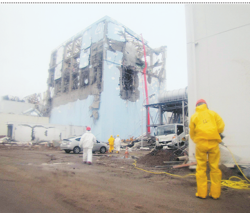
东京电力公司22日发布的照片显示,工作人员向福岛第一核电站4号反应堆喷水。新华社发
