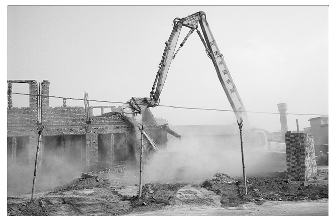
昨日,二七区侯寨乡一天拆除了五处违法建筑。侯寨乡对在建建筑进行分类,对不符合条件的违法建筑通知其自行拆除,预期不能自行拆除者有关部门实施强制拆除。 本报记者 安群英 摄
