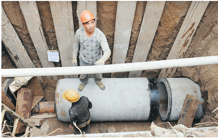
昨日,在惠济区长兴路办事处银河路上,工人们正在进行雨污分流改造顶管施工。据悉,此次除了铺设新的雨污分流管道,还将改造水系不畅通的管道,力争彻底解决雨污水管混接、乱接现象,提高生活污水收集能力。 本报记者 许大桥 摄
