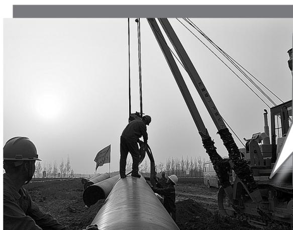
4月29日,国家重点工程西气东输平顶山—泰安支干线新郑二标段工地紧张施工。据了解,西气东输新郑段全长54公里,于4月7日开工建设,计划8月底全线贯通,10月底达到投产条件。
