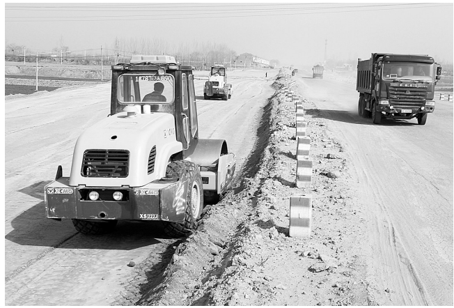
被列为“2011年新郑十大工程”的郑新快速通道是未来黄帝故里新郑连接郑州的重要通道。昨日,记者在郑新快速通道施工现场看到,筑路车辆来回穿梭,施工人员加紧施工,现场一派繁忙景象。 本报记者 高凯 摄
