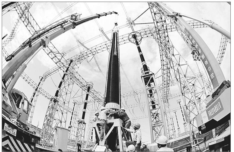
电力工人正在争分夺秒建设1000千伏特高压输电工程
