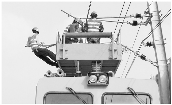
深圳地铁四号线二期工程于6月16日正式开通运营。作为国内第一条由香港铁路公司在内地投资建设并负责运营的城市地铁项目,其中被称为“地铁中枢”的机电系统工程,由驻郑中铁电气化局三公司负责承建。本报记者 陈靖 摄
