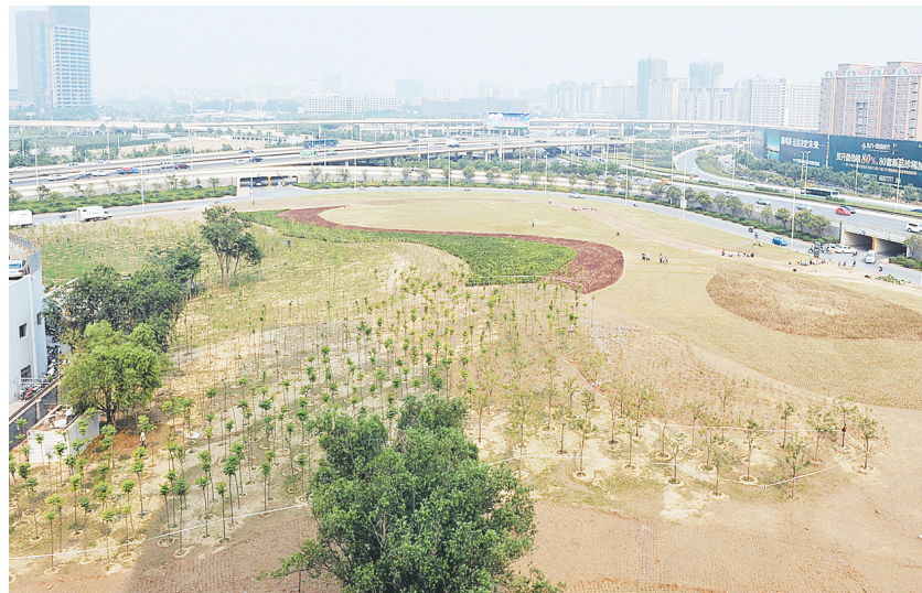
金水路立交桥下金中绿地绿化美化工程昨日完工。
