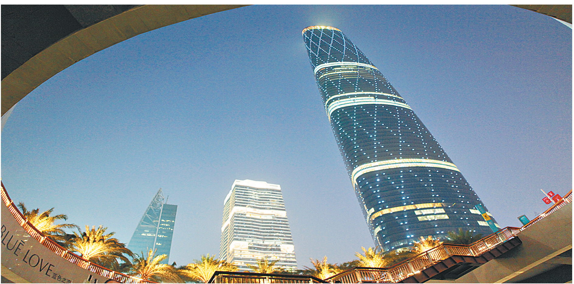
矗立在新城市中轴线上的广州国际金融中心，呈现出浓厚的现代气息，成为广州最具国际视野的地标建筑。
