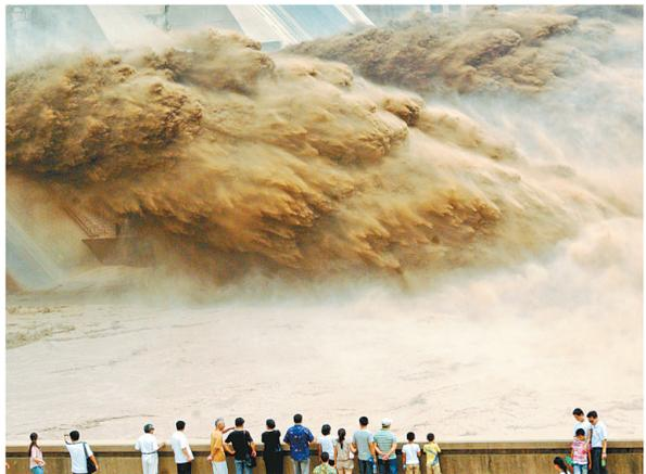
7月4日18时起,黄河小浪底水库开始排沙,裹挟着泥沙的混浊水流从小浪底出水口排沙洞喷涌而出,十分壮观。黄河2011年度调水调沙自6月19日开始实施,通过万家寨、三门峡水库加大下泄流量,在小浪底水库区形成高含沙水流,人工塑造异重流并排沙出库。
