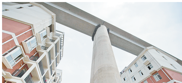
安徽省合肥市长丰县双墩镇的双凤里小区楼房上横跨着正在建设中的合蚌高铁专线的枢纽线(8月10日摄)。 新华社发
