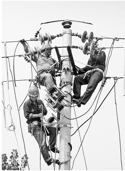
伴随着中牟县九龙镇辖区企业的不断入驻,用电量和用电负荷一增再增。为确保农民农业用电、工业有序用电,让辖区居民企业用电无忧,中牟县电业局电力安装公司第三工程队的工作人员头顶烈日,加班加点,一直在和工期赛跑。 本报记者 卢文军 摄
