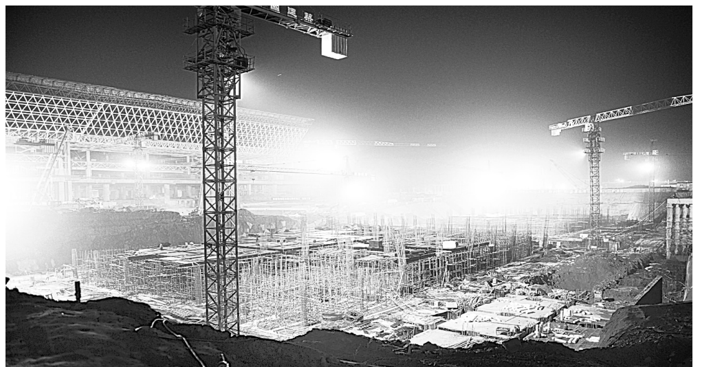
市综合枢纽西广场及5号线市域线工程建设夜景
