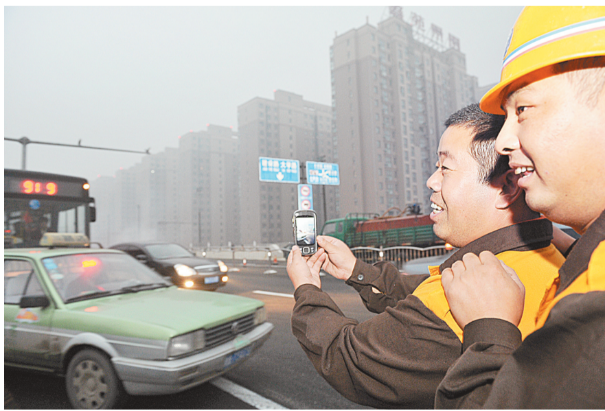
高阳桥维修工程的建设者们兴奋地用手机拍摄通车场面。
