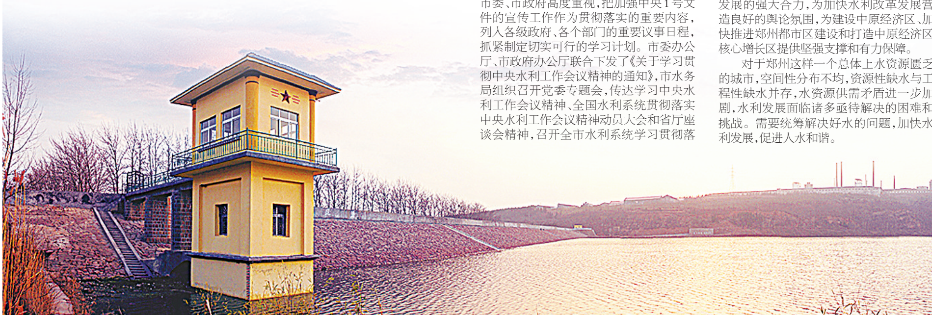
除险加固后的朝阳沟水库
