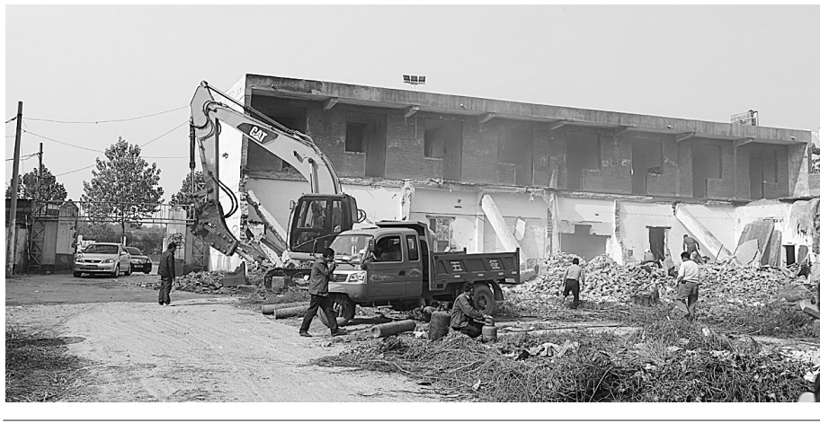
27日,长兴路街道辖区宏达路拆迁打通工程正式开始。该路为城市次干道,东起金杯路,西至江山路,全长986米,投资1000万元。本报记者 黄永东 摄
