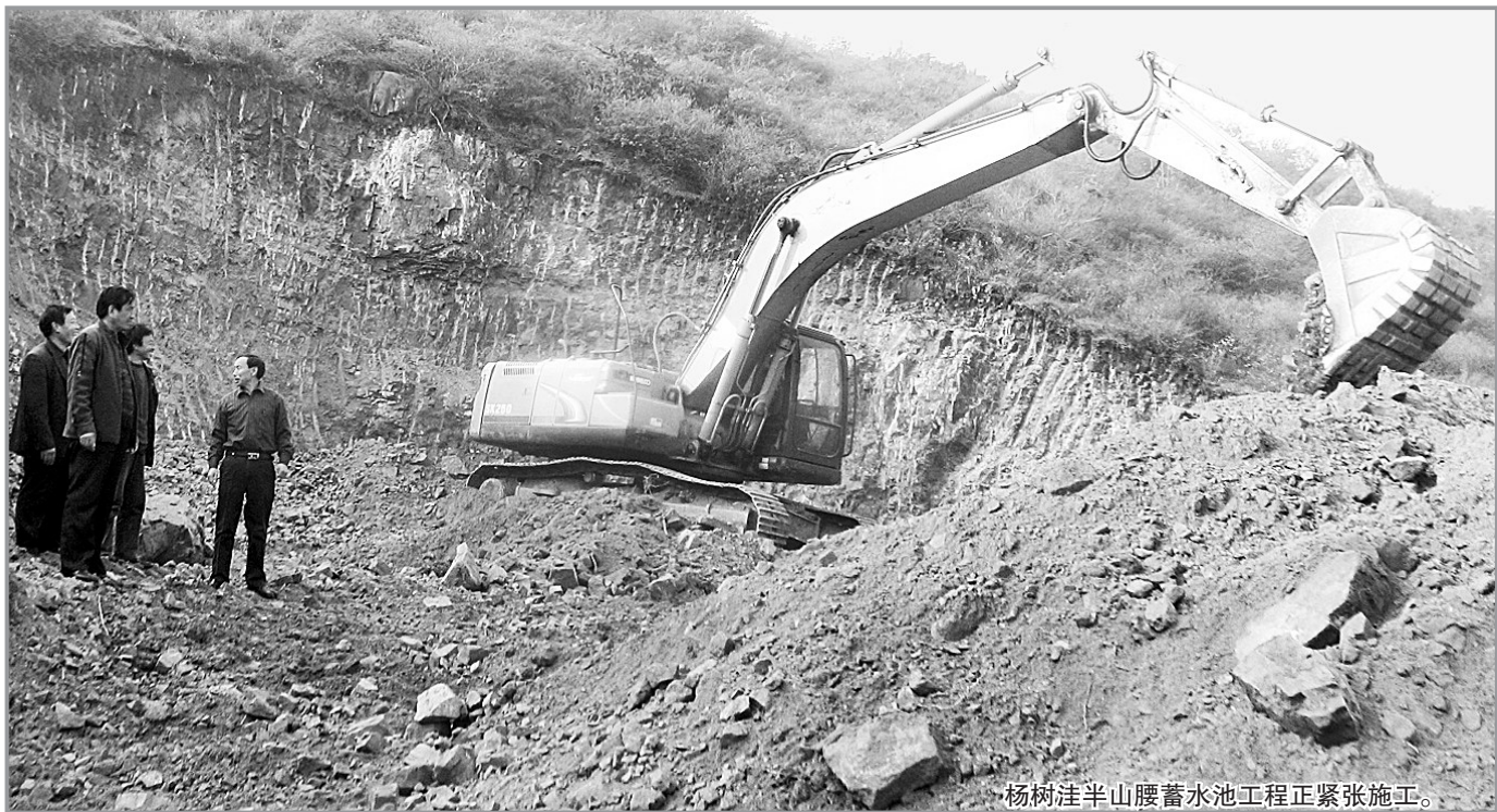
杨树洼半山腰蓄水池工程正紧张施工。
