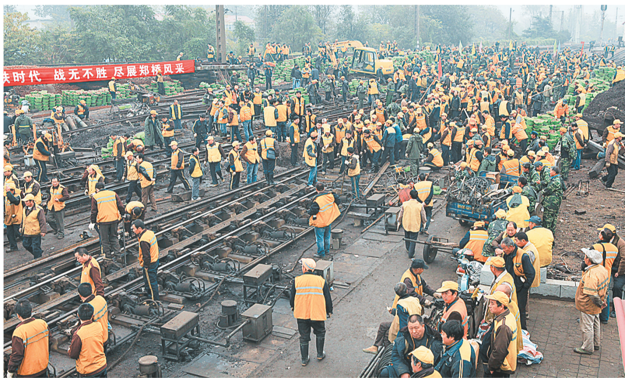
8日5时,素有全国路网“心脏”之称的郑州铁路北站,在上编驼峰进行建站以来最大规模的“换心”手术,800余名职工对驼峰5组咽喉道岔进行大换装。据了解,此次施工至12月20日结束,将更换75组咽喉道岔。本报记者 宋晔摄
