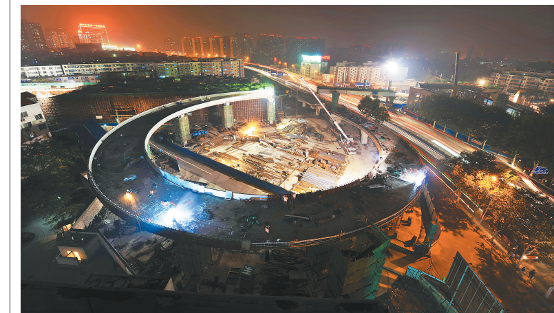
京沙快速路(沙口路立交)
