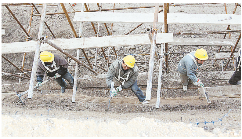
在商城遗址南城垣西段,施工人员在城墙本体上覆土,填实裂缝沟壑,加固城墙。
