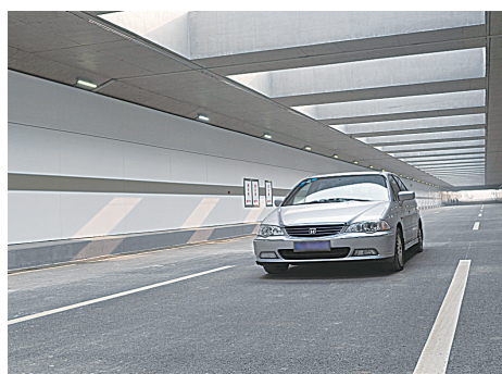
我市第一条功能齐全智能化隧道建成
