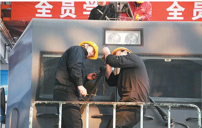
为确保春运期间旅客列车运行安全,郑州机务段对现配属、使用的337辆机车进行“拉网式”检查整修,彻底消除安全隐患。
