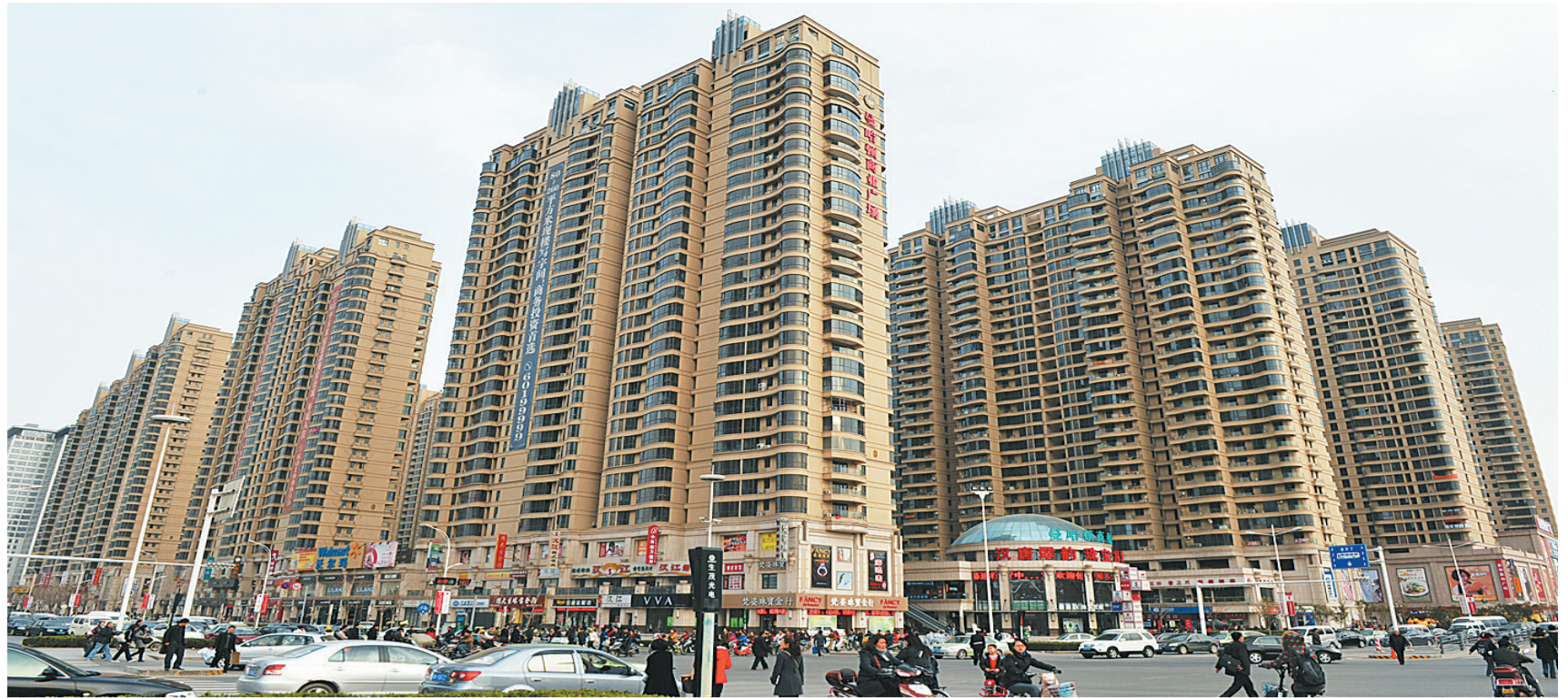
金水区燕庄拆迁改造后变成了高楼林立的曼哈顿商业区
