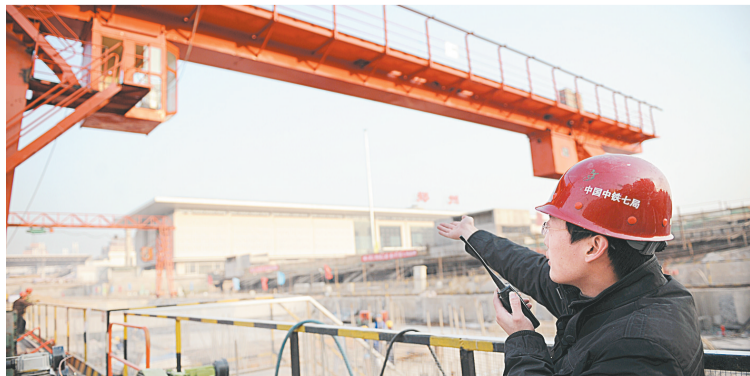
地铁施工，文明有序
