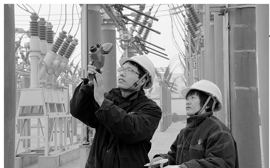
1月3日,新郑市供电公司110千伏城后变电站工作人员在进行不停电测温工作。该单位针对冬季供电负荷攀升,用电高峰连续出现的实际,发动各站运行人员采取带电作业新技术,改变不停电测温给群众生活和经济建设带来的影响和损失。
