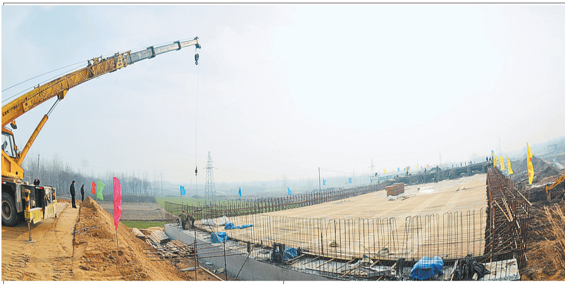
郑州至新郑快速通道改建工程正加快推进,预计新郑段春节前实现半幅通车。 本报记者 唐强 摄
