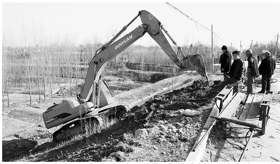
正在施工中的新密市河西水库除险加固工程。
