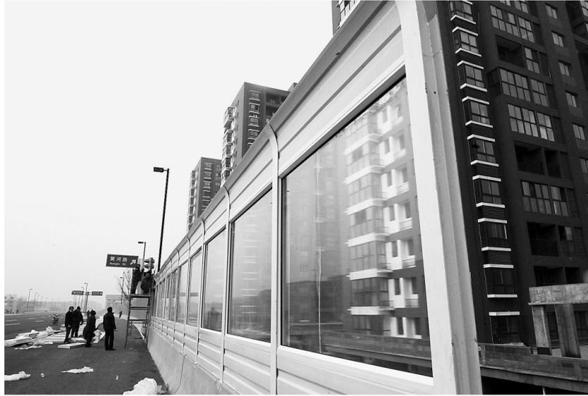
昨日,记者在京沙快速路跨陇海铁路立交施工现场看到,工人们正在安装隔音墙,减少通车后过往车辆对附近居民楼的噪音污染。安装隔音墙至少能降低10分贝。 本报记者 陈靖 摄
