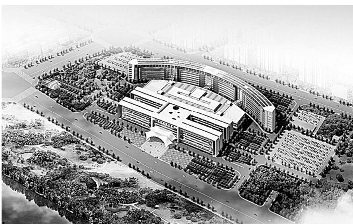
一标段为病房楼工程,建筑面积42898平方米,框架结构,地下1层,地上7层,长约276米,宽21米,高29.5米。施工过程中,施工方克服地方关系复杂、管桩、钢筋及钢管扣件市场供应紧张及劳务市场人力资源紧张和劳务工资大幅上涨等种种困难,积极推进工程有序进展。目前,病房楼工程已提前竣工。
