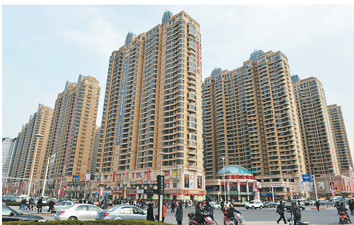
燕庄经过改造后,变成了现代化商业区。
