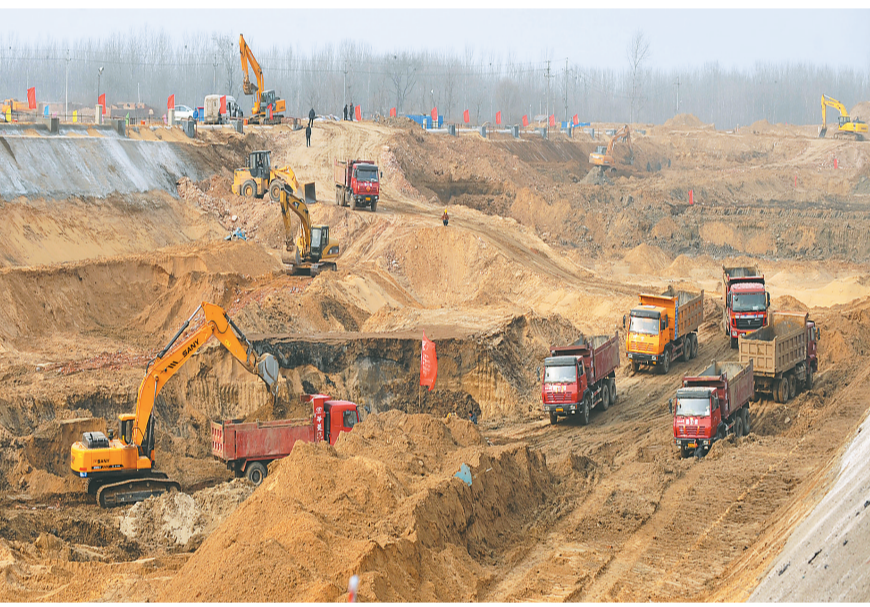
昨日,郑东新区龙湖区如意东路至龙源十三街隧道工程工地上,施工人员正在紧张作业。该项目是我市重点工程,隧道全长3150米,采用双向六车道设置,开工以来,已开挖土方9万立方米。 本报记者 丁友明 摄
