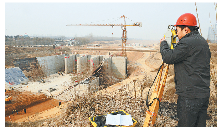
南水北调中线工程二七区段河道控导项目——金水河与干渠河道交叉倒虹吸建设工程目前主体工程已全部完工。据了解,该项目总投资6000万元,建筑物总长364米,倒虹吸设计流量295立方米/秒。
