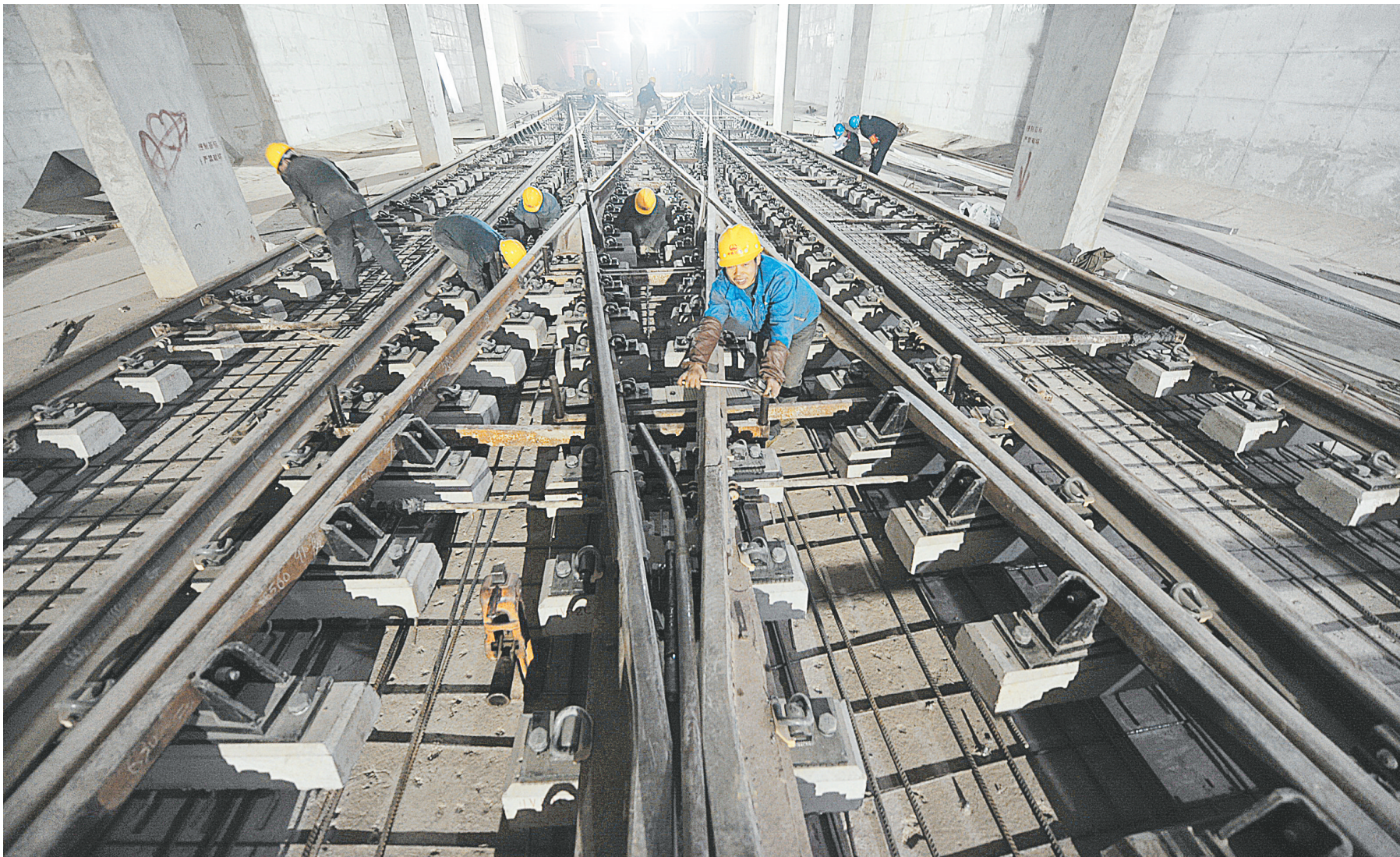
为了圆市民多年的地铁梦,施工人员正在加紧完成铺轨工作。
