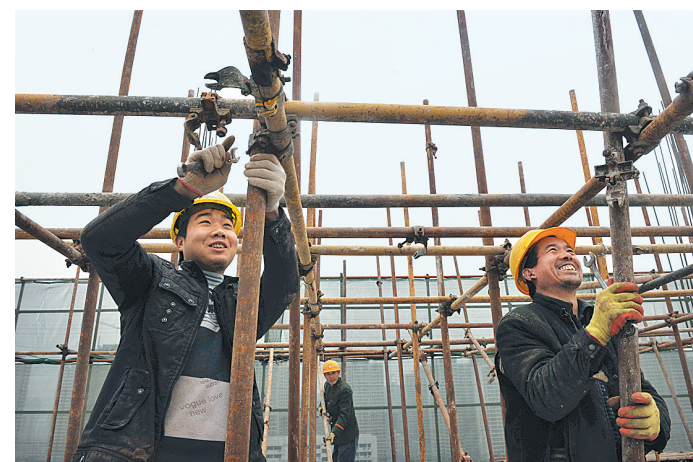
郑州市第二人民医院新建病房楼正在施工中,新建病房楼开设床位将达1022张,预计在2013年6月竣工。
