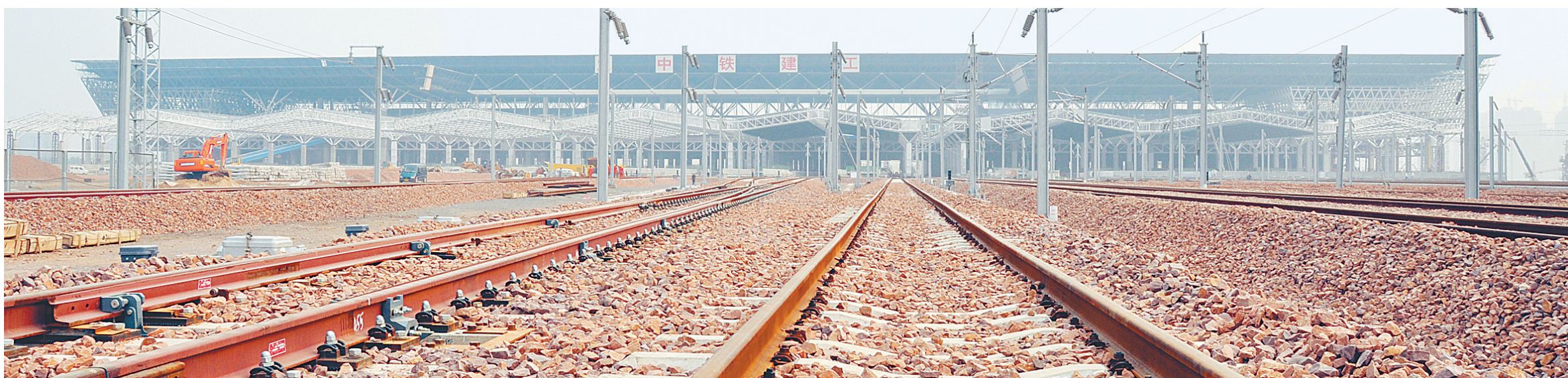
条条铁轨延伸向站台,新东站工程已形成规模。
