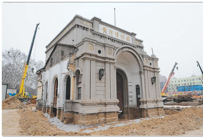
2月29日,黄河博物馆主楼地基已经清理结束。为配合郑州地铁建设,黄河博物馆将采取主楼平移、附属用房保护性拆除的方法进行拆迁,现在的黄河博物馆主楼向东平移100多米,附属建筑物予以拆除,待地铁施工完成后再次恢复建筑原貌。黄河博物馆建于1955年,是世界上最早成立的江河博物馆之一。
