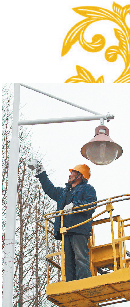
灯杆柱、围栏等统一刷白，城市形象焕然一新。
