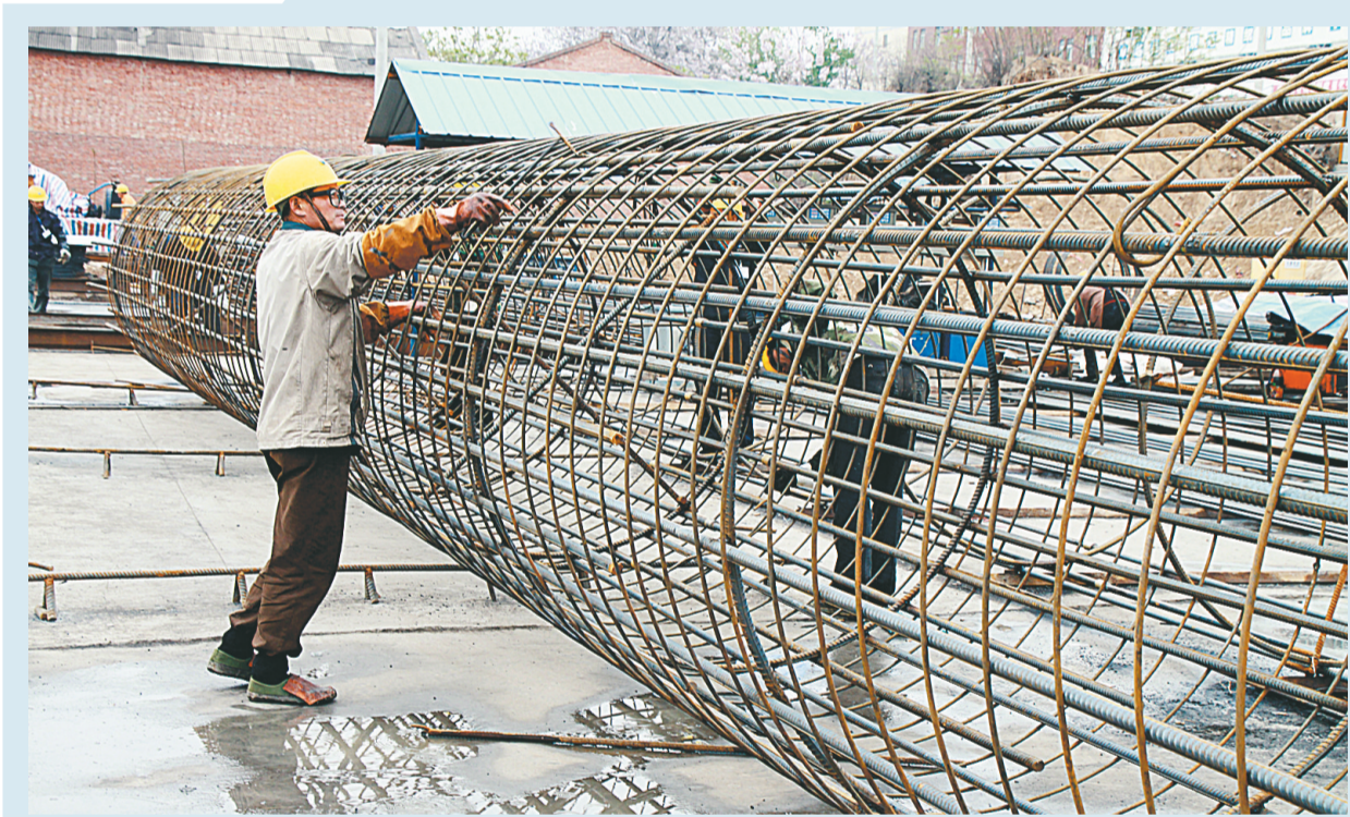
施工人员在捆扎基桩钢筋骨架。
